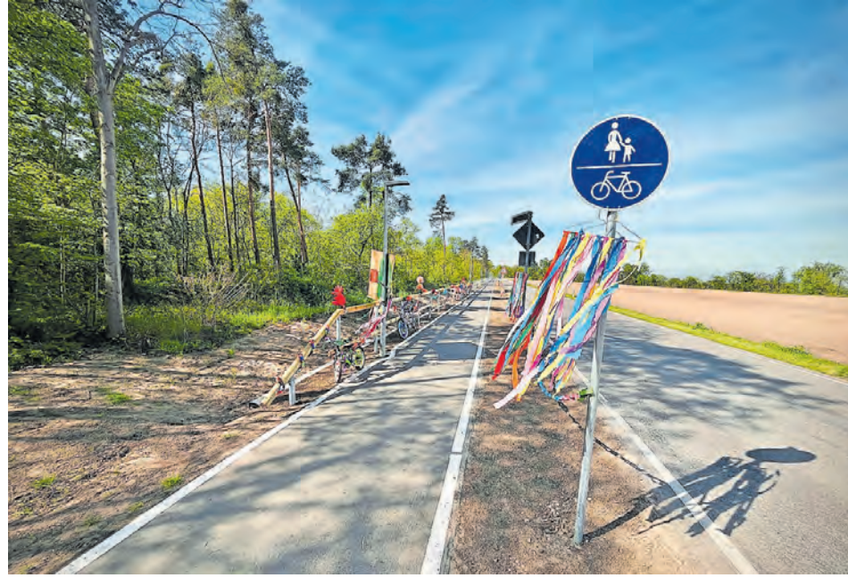
Der gemeinsame Fuß- und Radweg verbindet den Ortsausgang Blumenau mit der Eugen-Neter-Schule FOTO: STADT MANNHEIM
